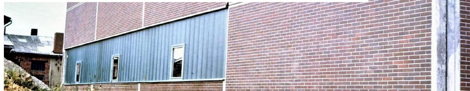
Cette matrice a sa particularité. Elle ne sert pas à produire une structure à la surface du béton. Au lieu de cela, des briques y sont déposées avant que le béton n'y soit coulé. Les briques se lient alors durablement à la pierre artificielle pour constituer une parfaite façade évocatrice d'un mur de brique classique.
