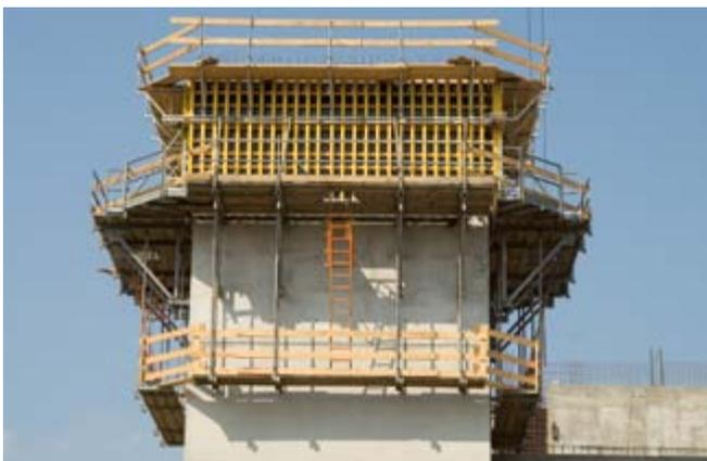
*Eine ideale Kombination: NOEtec und die Klappbare NOE Arbeitsbühne AB 300. Nacharbeiten erfolgten von der untergehängten Bühne aus.*
