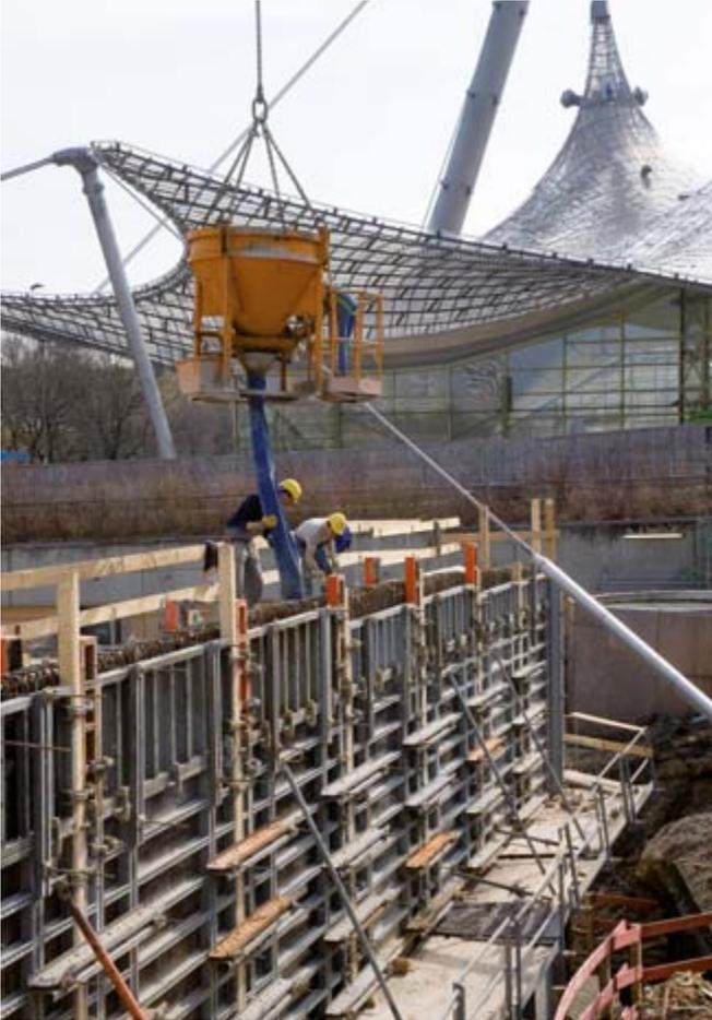
Die Wände der Halle sind vorwiegend in Sichtbeton ausgeführt und die Lage der Spannstellen ist von den Architekten vorgegeben. Eine Aufgabe für die die NOEtop mit ihrer integrierten Gurtung geradezu prädestiniert ist.
