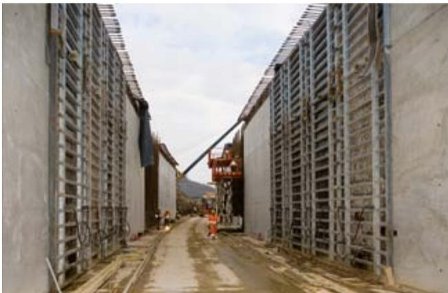
Bei Bau des 168 Meter langen Troges setzte Baresel NOEtop Großflächenschaltafeln ein. Diese überzeugte besonders durch die integrierte Gurtung und die größte auf dem Markt erhältliche Rahmenschaltafel mit einer Abmessung von 5,30 x 2,65 Meter und über 14 m<sup>2</sup> Schalfläche.
