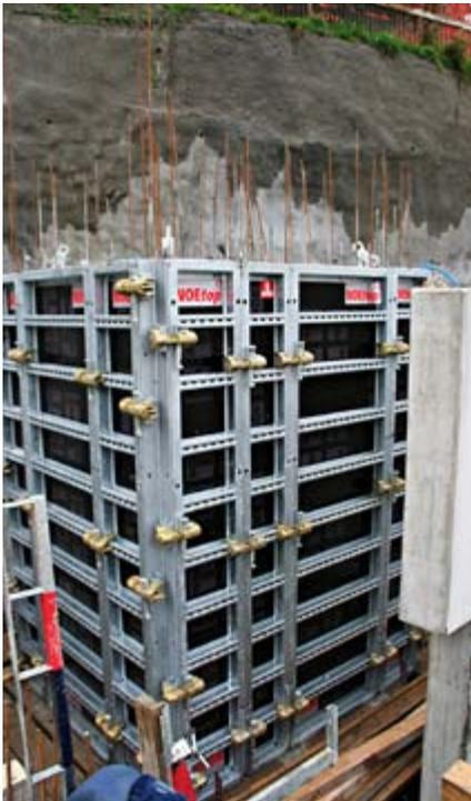
*NOEtop Schachtschalung vorbereitet zum Betonieren. Sehr gut sichtbar, die sinnvolle Anordnung des Hebelkopfes. Dieser lässt sich bewegen, ohne dass man mit der Bewehrung ins Gehege kommt.*
