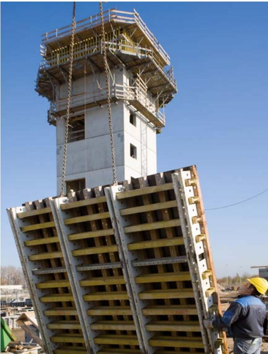
*Für die Treppenhäuser der Pilotanlage war SB 3 vorgegeben. Realisiert hat Baresel dies mit der flexiblen Trägerschalung NOEtec.*
