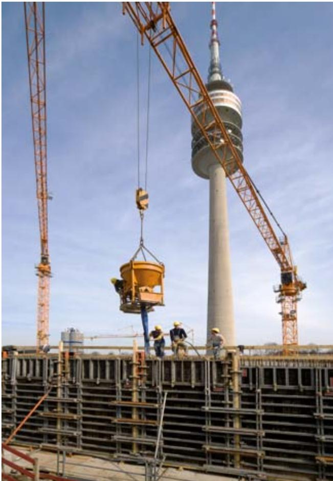
Die GroBelemente der NOEtop Rahmenschalung mit integrierter Gurtung sowie ein durchgängiger, schlüssiger Tafelraster halfen dem ausführenden Bauunternehmen Xaver Riebel die Vorgaben zur Zufriedenheit der Architekten umzusetzen.
