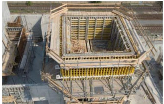
*NOEtec macht es möglich: Wegen der horizontal angeordneten NOEtec Träger wurden für die Außenschalung der Treppenhäustürme nur vier Schalelemente benötigt.*
