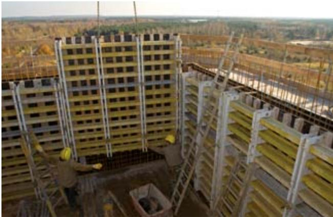
*NOEtec Träger lassen sich horizontal und vertikal anordnen. So konnte mit kleineren Elementen die Innenschalung der Treppenhäustürme rationell ein- und ausgeschalt werden.*
