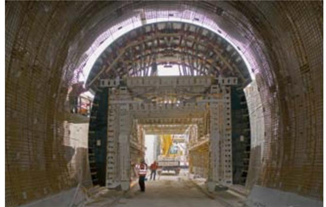
Bereit zum Verfahren – der NOEtec Schalwagen. Hydraulisch abgesenkt und die Seitenwände eingefahren. Je Takt benötigte die Baustellen-Mannschaft im Zwei-Schicht-Betrieb nur 1 ½ Tage.
