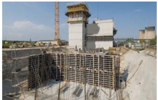
*Neben der NOEtec Trägerschalung überzeugte NOE mit den Großflächenelementen der NOEtop Rahmenschalung.*
