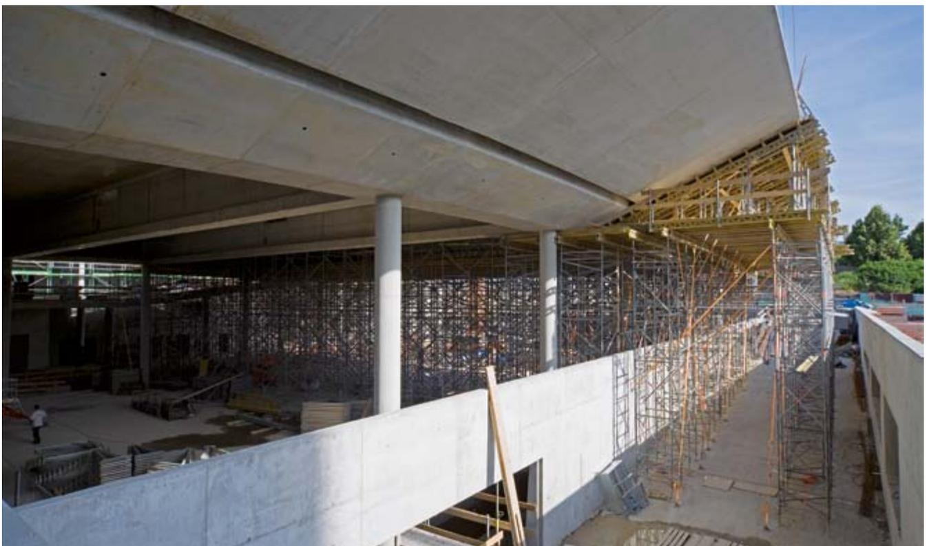
Gewölbte Deckenflächen sowie viele geneigte Wände, ausgeführt in Sichtbeton, sind das Markenzeichen der „Neuen Kleinen Olympiahalle“. Im Einsatz NOE ST 200 Stapeltürme und NOEtop Rahmenschalung.
