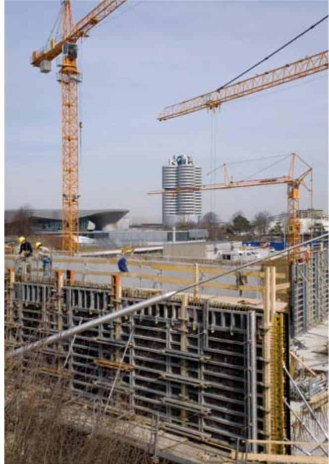
Die integrierte Gurtung macht aus der NOEtop eine „Trägerschalung“ – nur so ließ sich das von den Architekten geplante Fugenraster von 1,5 x 3,0 Meter in der gewünschten Präzision realisieren.
