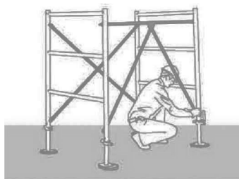
◆ Positionner une diagonale et une K-diagonale sur les grands côtés, fixer en même temps la sécurisation des vérins de pied.
