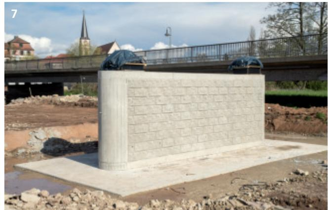
Titelbild: Wenn die Betonoberflächen etwas „Patina“ angesetzt haben, wird nur noch der Fachmann auf den ersten Blick erkennen, dass es sich um eine strukturierte Betonoberfläche handelt und nicht um eine Natursteinverblendung.
