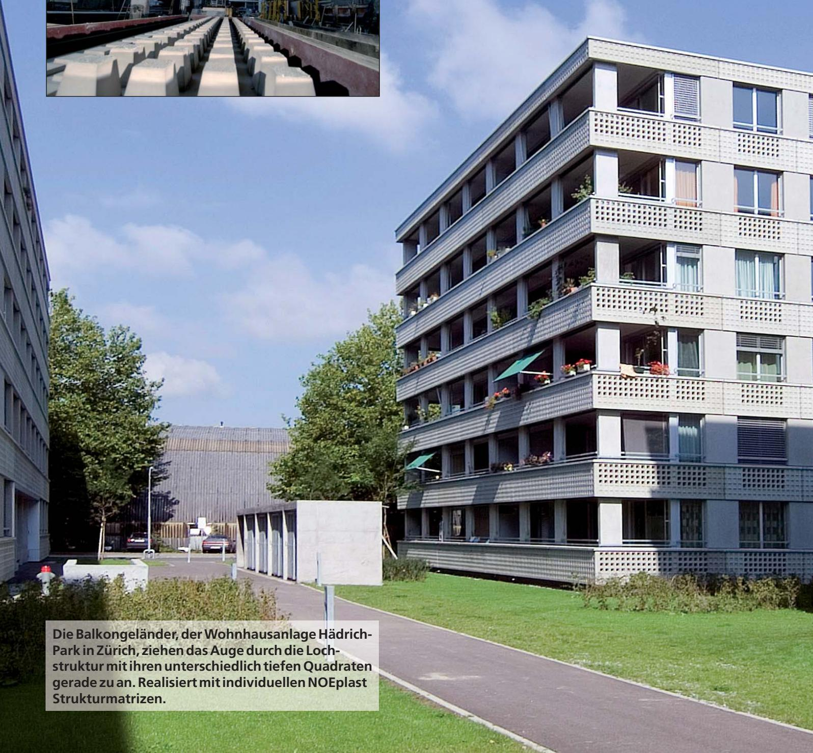
Die Balkongeländer, der Wohnhausanlage Hädrich-Park in Zürich, ziehen das Auge durch die Lochstruktur mit ihren unterschiedlich tiefen Quadraten gerade zu an. Realisiert mit individuellen NOEplast Strukturmatrizen.
