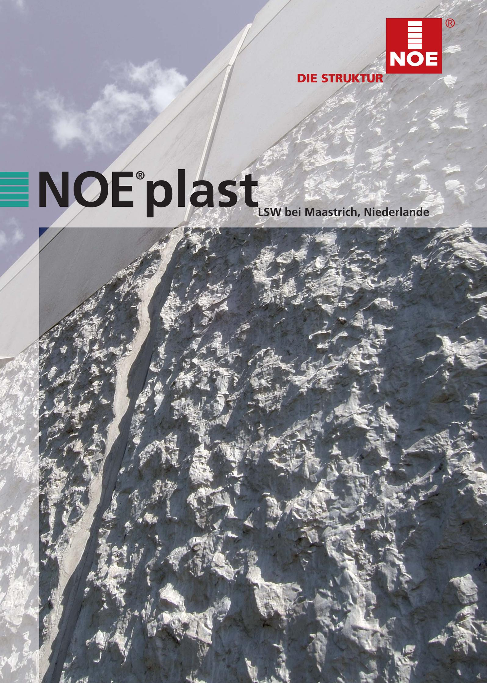
Die Lärmschutzwand bei Maastrich, Niederlande ähnelt einer aus Stein gehauenen Mauer, welche eine Grenze zwischen lärmender Straße und Bevölkerung bildet. Realisiert mit der NOEplast Stein-Struktur „Granit IV“.
