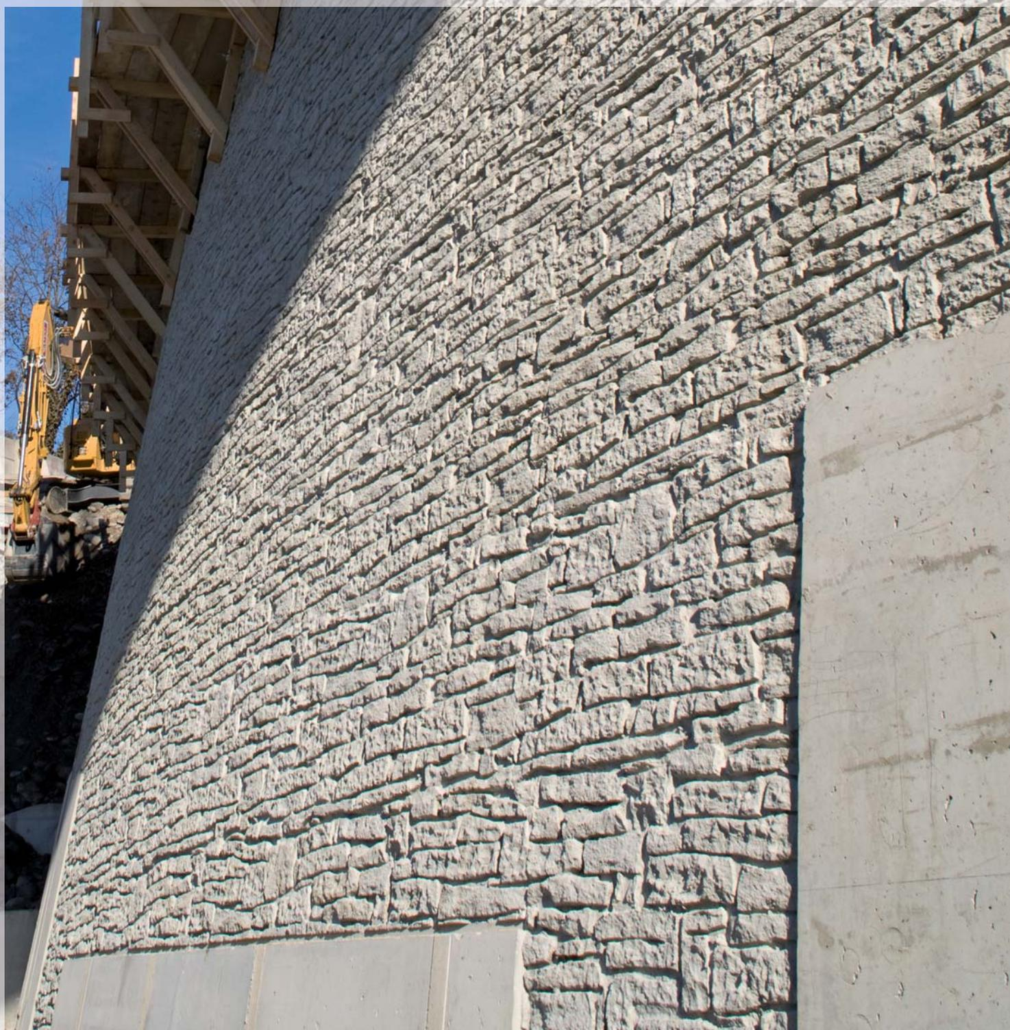
Der Ausbau der B 171 in Landeck an der neuen Landecker Innbrücke der Arlbergbahn erforderte den Bau einer Stützwand. Um sie optisch an die bestehende anzupassen wurde die NOEplast Mauerwerk-Struktur „Murus Romanus“ eingesetzt.
