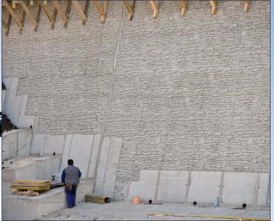
Der Ausbau der B 171 in Landeck an der neuen Landecker Innbrücke der Arlbergbahn erforderte den Bau einer Stützwand. Um sie optisch an die bestehende anzupassen wurde die NOEplast Mauerwerk-Struktur „Murus Romanus“ eingesetzt.
