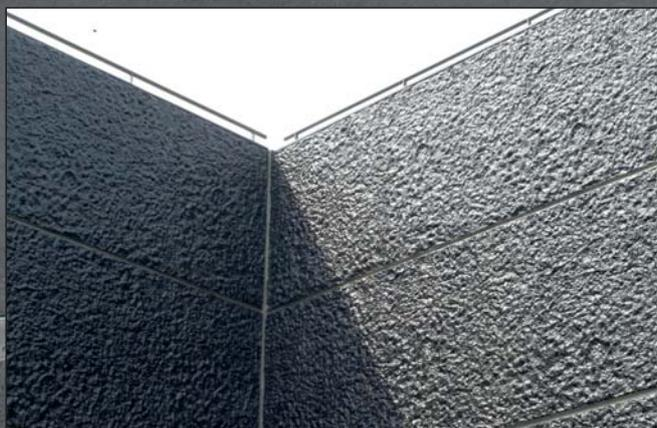
Die Fassade des Laborgebäudes im französischen Verrieres le Buisson wurde mit der NOEplast Stein-Struktur „Granit III“ gestaltet. Die schwarze Lasur verleiht dem Gebäude ein geheimnisumwittertes Äußeres.
