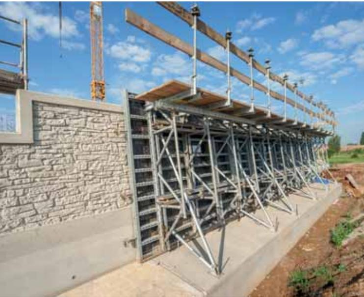
Bei der NOE Combi 70 erfolgt die Verspannung im Sockelbereich und über der Schalung. Es gibt keine störenden Spannstellen im Sichtbetonbereich.
