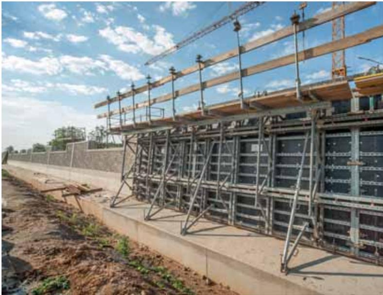
Die Elemente hatten eine max. Größe von 300 x 512,5 cm, sodass sich 9,60 m lange Wandsegmente mit nur 4 Schalelementen betonieren ließen.
