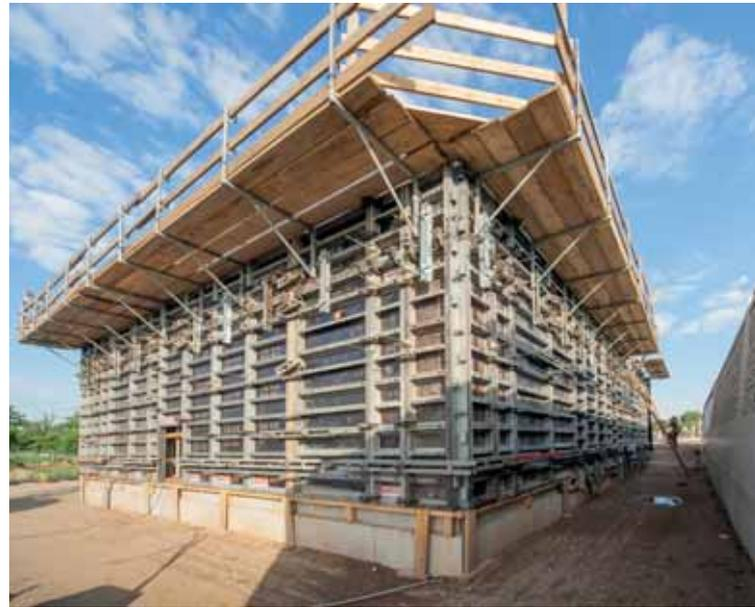
Für die Pumpengebäude an den Enden des Elbdeiches hatte sich das ausführende Bauunternehmen für das bewährte NOEtop Schalsystem entschieden.
