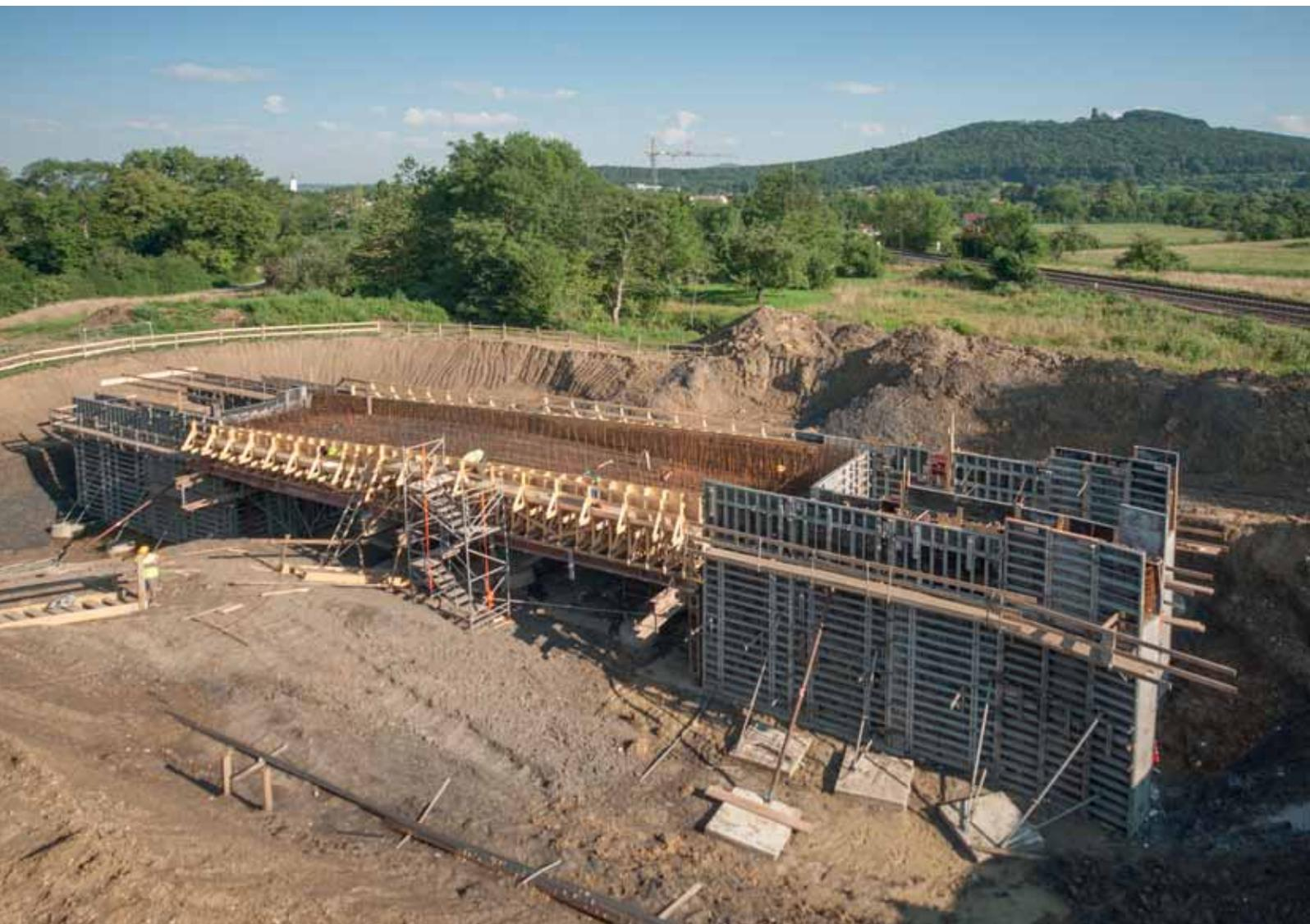
**In einem Guss betoniert** – NOEtop Wandschalung ermöglicht das Betonieren einer Brücke in einem Guss beim Bau der B 466 Ortsumfahrung Süssen **2**
