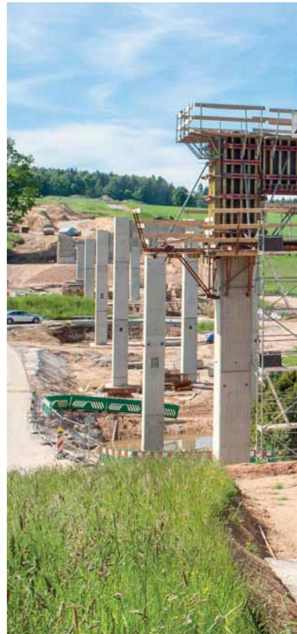
*Auf neun bis zu 16 m hohen Pfeilerpaaren wird die Kirchberger Umgehungsstraße das Tal des Leutersbachs überqueren. Der 25-cm-Breitenraster der NOEratio Trägerschalung erwies sich bei den filigranen Querschnitten der Pfeiler als besonderer Pluspunkt beim Bau der Brücke.*
