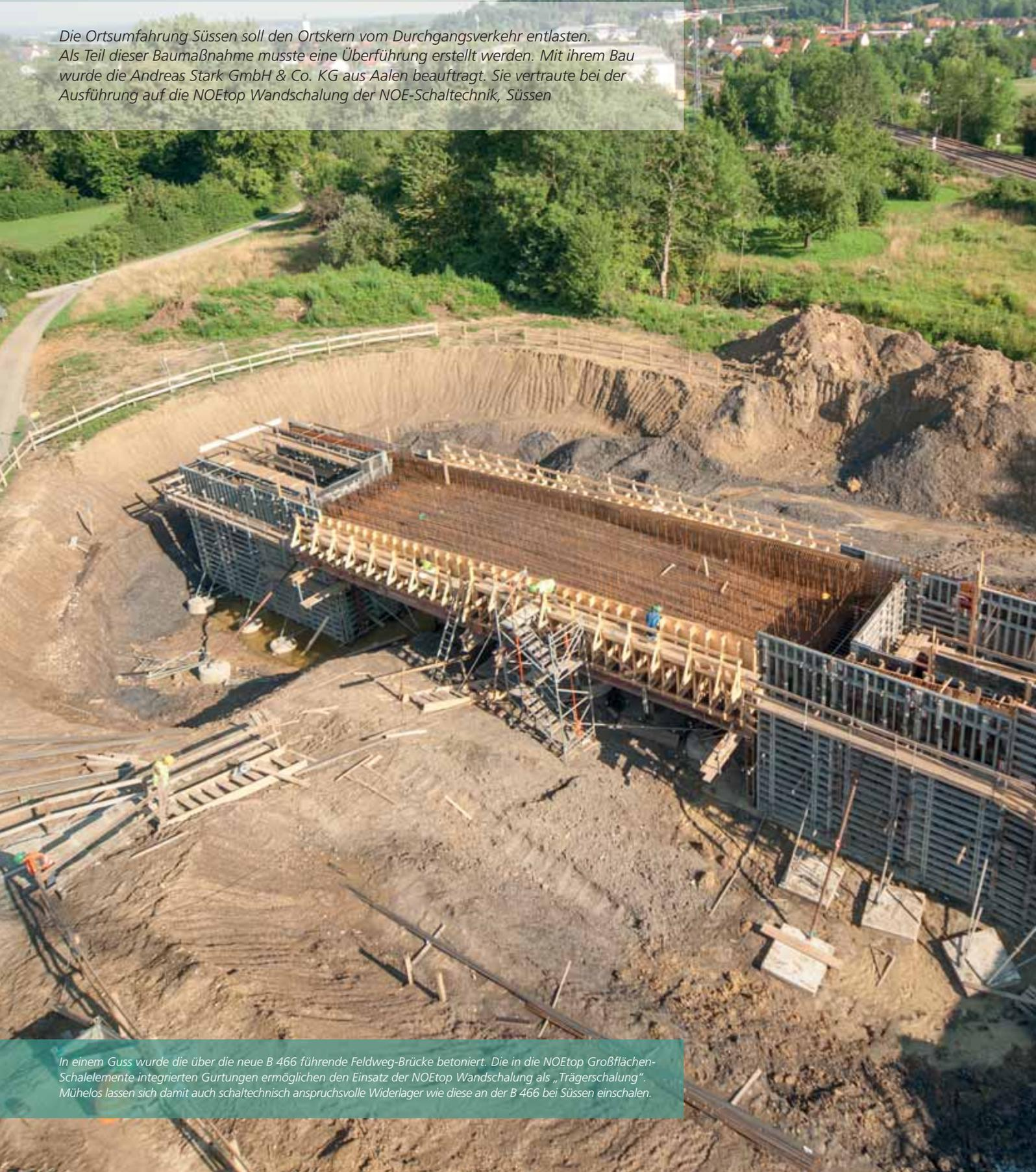
*In einem Guss wurde die über die neue B 466 führende Feldweg-Brücke betoniert. Die in die NOEtop Großflächen-Schalelemente integrierten Gurtungen ermöglichen den Einsatz der NOEtop Wandschalung als „Trägerschalung“. Mühelos lassen sich damit auch schaltechnisch anspruchsvolle Widerlager wie diese an der B 466 bei Süssen einschalen.*
