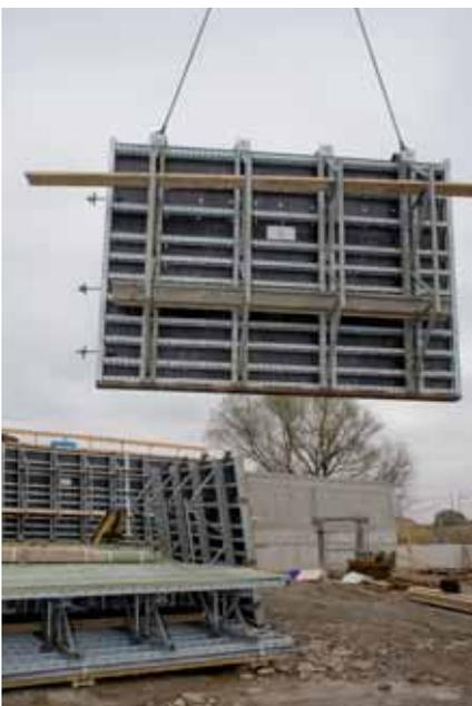
NOE Combi 70 – ein Schalsystem, das vorzugsweise im Wohnungsbau zum Einsatz kommt, wenn glatte, tapezierfertige Betonoberflächen gefordert sind, weil sich die Verspannung im Sockelbereich bzw. über der Schalung befindet. In Cossebaude wurde dies genutzt, um die Sichtbetonflächen spannungsfrei zu gestalten.
