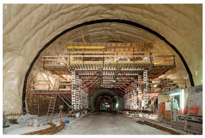
fläche von ca. 100 m² in einem Arbeitsgang betonieren. Nach dem Aushärten des Betons wurde der Schalwagen mit Hilfe einer Hydraulik um ca. 20 cm abgesenkt und der Schalwagen zum nächsten Abschnitt verfahren. Für die Rückunterstützung verwendete Züblin NOE LS 200 Schwerlaststützen.
