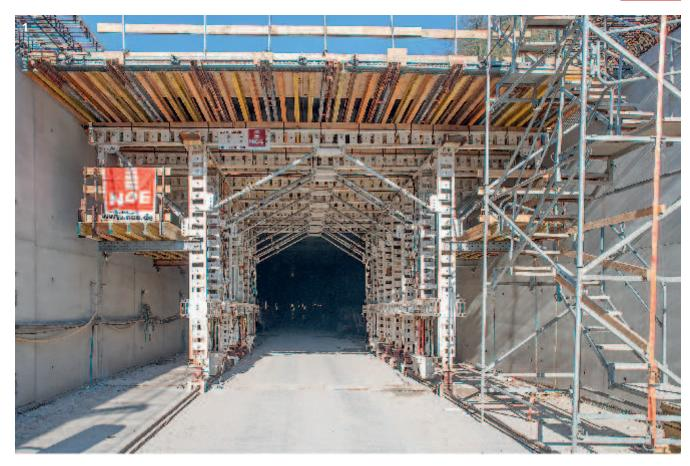
Im Zuge der Ortsumfahrung der Stadt Schriesheim erfolgt der Bau des 1796 m langen Branich-Tunnels. Für den Bau des Tunnels entwickelte NOE-Schaltechnik mit seinem äußerst flexiblen Schalungssystem für Ingenieurbauwerke NOEtec zwei Schalwagen, die völlig unterschiedliche Aufgaben zu erfüllen hatten und deren Größe zum Teil veränderlich sein musste.
