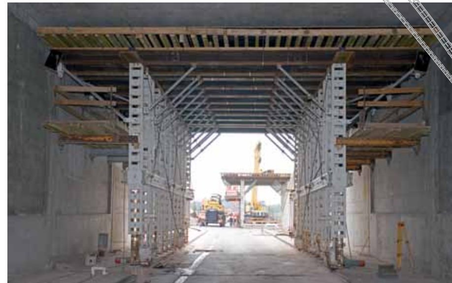
Construction à ciel ouvert est : le chariot en arrière-plan est préparé pour son déplacement de la galerie sud à la galerie nord
