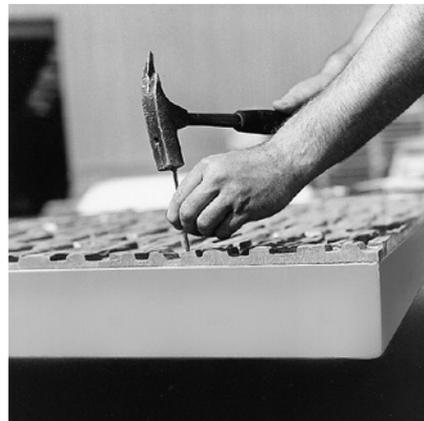
Matten an den Ecken annageln oder anschrauben bei Stahlschalungen evtl. mit Schraubzwingen niederhalten (siehe Fotos). Darauf achten, dass die ganze Fläche angedrückt wird.
