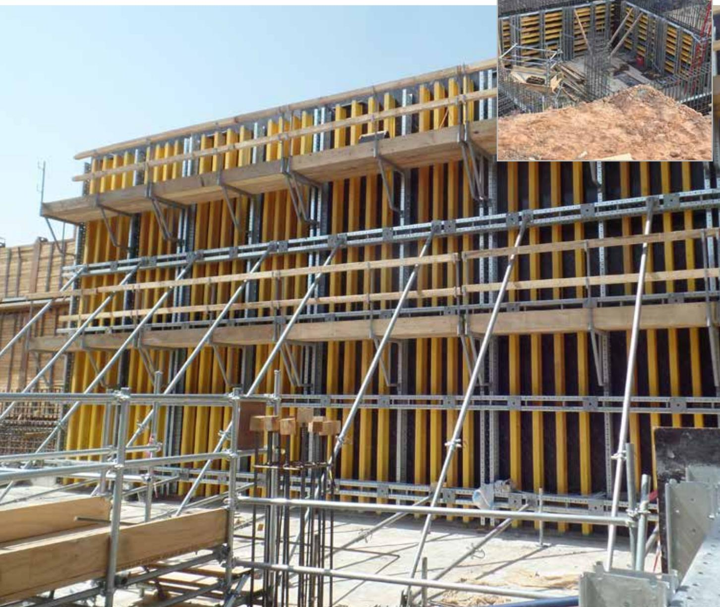
Les étais NOEprop en aluminium se distinguent par un faible poids propre et une grande force portante pouvant aller jusqu'à 160 kN/étau. Avec les cadres d'étau NOEprop, ils forment un système d'étaielement flexible et performant.
