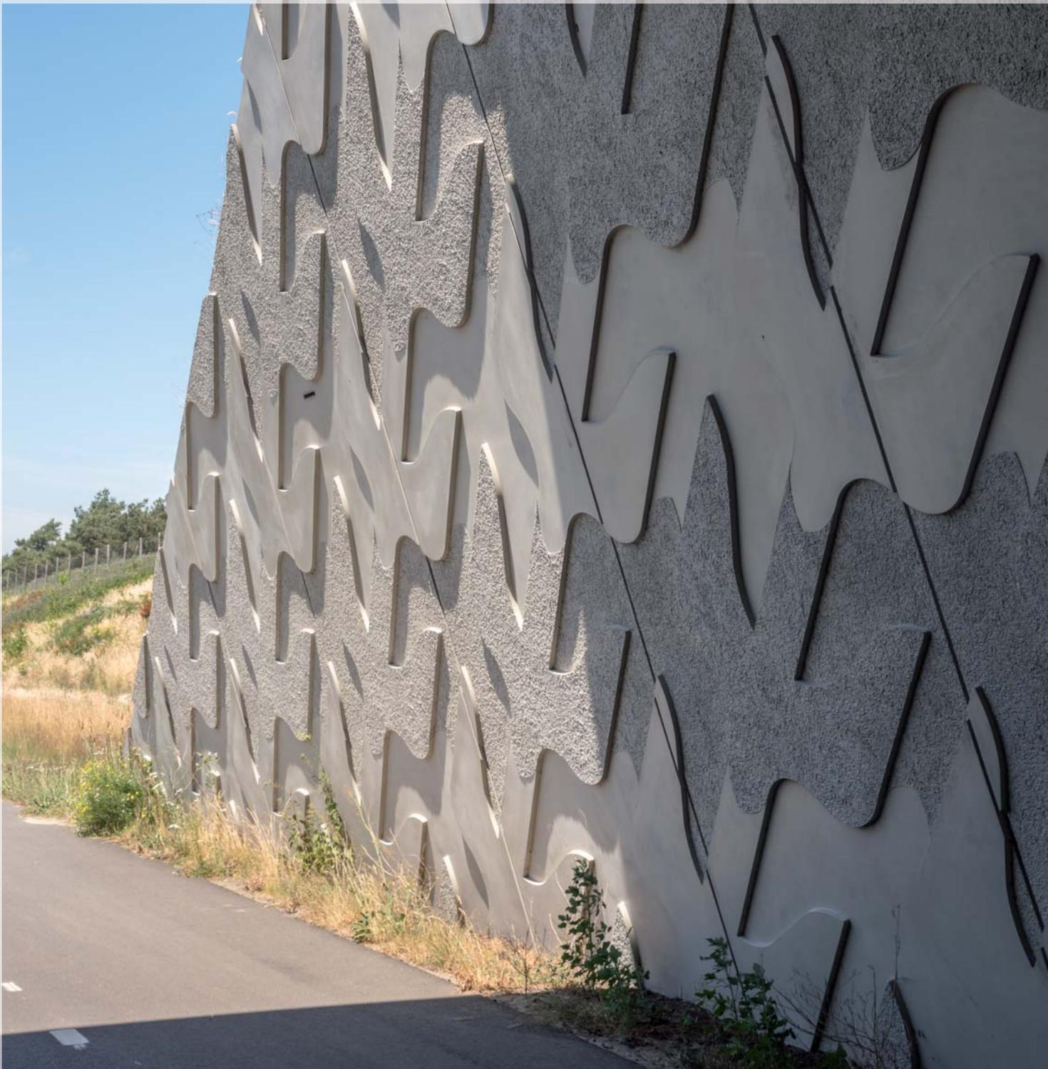
Die Wände der Widerlager einer Grünbrücke in Weert, Niederlande zeigen stilisierte Vögel. Realisiert mit NOEplast Strukturmatrizen.
