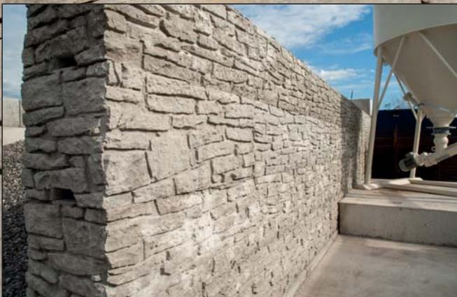
Großformatige „Lego-Bausteine“ z. B. für Stützwände mit unterschiedlichen Oberflächen-gestaltungen durch NOEplast Strukturmatrizen: Mauerwerk-Struktur „Murus Romanus“ Mauerwerk-Struktur „Berlin“ Stein-Struktur „Granit III“
