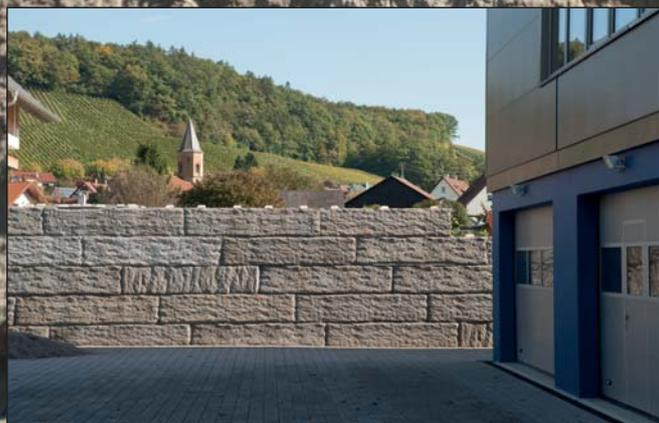
Großformatige „Lego-Bausteine“ z. B. für Stützwände mit unterschiedlichen Oberflächen-gestaltungen durch NOEplast Strukturmatrizen:
