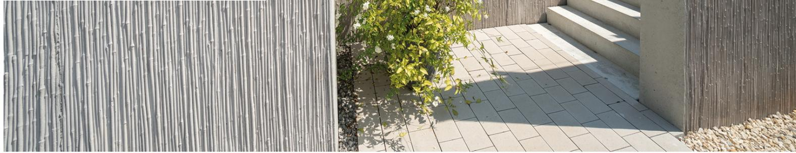
Bei dieser Matrizze ist der Name Programm. Sie gestalten eine Betonoberfläche mit dem natürlichen Charakter einer Bambusmatte. Hier wurden im Vergleich zur Madras dickere Rohre verwendet.
