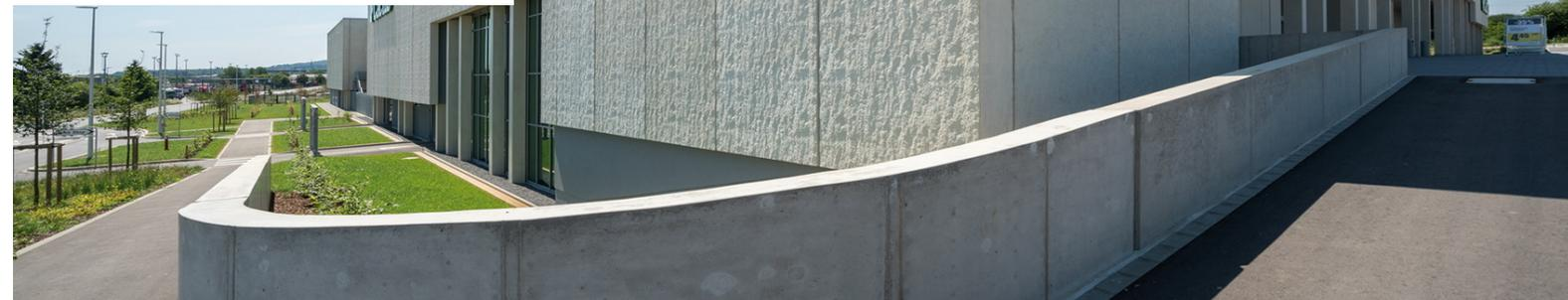
Cette matrice confère au béton l'apparence d'un gros bloc de granite à la surface grossièrement bosselée. Le sens de la structure doit être pris en considération au fil de la planification.
