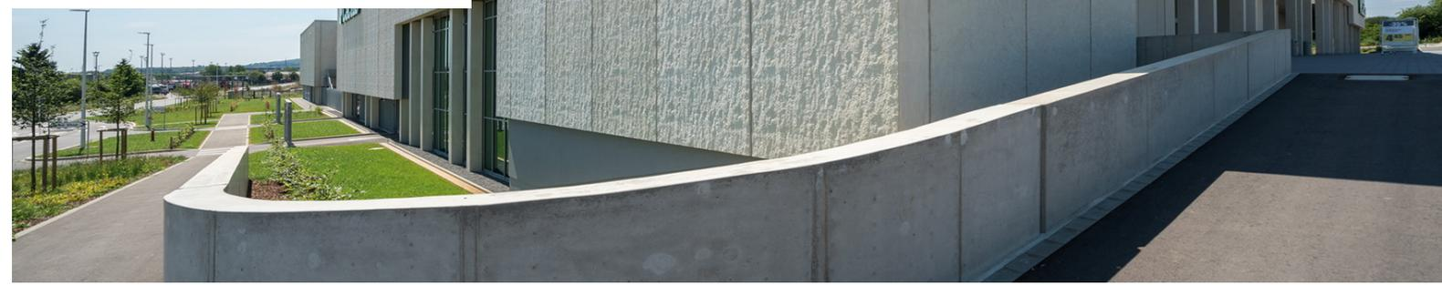
Diese Matrice verleiht dem Beton das Aussehen einer großen Granitsteinplatte mit einer grob bossierten Oberfläche. Im Zuge der Planung sollte die Strukturrichtung mit in Betracht gezogen werden.
