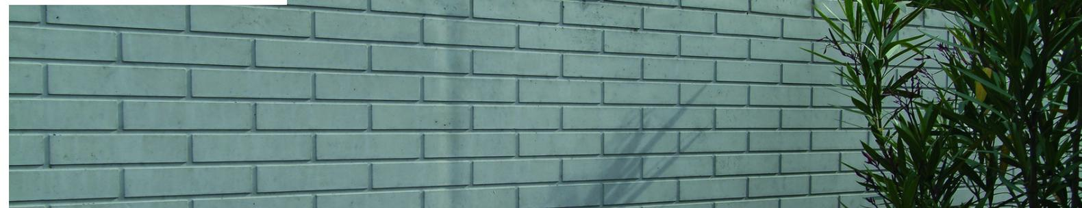
Les surfaces en béton créées à partir de cette matrice rappellent les murs en pierres de parement, chacune au format 240 x 54 mm. Les murs en béton présentent toutefois l'avantage d'être d'une pièce et leur dressage prend considérablement moins de temps.
