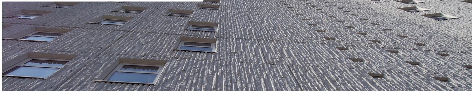
Le modèle Hong Kong crée une impression de poutres en bois fendues ou grossièrement taillées. Celles-ci peuvent s'utiliser à la verticale ou à l'horizontale. Il est possible de prolonger la structure par simple engrenage.
