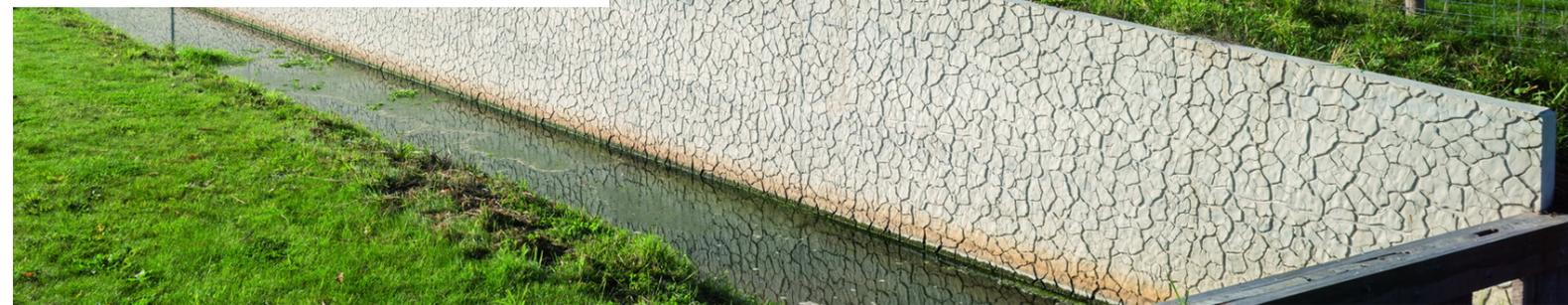
Argile sèche, craquelée – telle est la première impression qui vient à l'esprit de l'observateur de cette surface bétonnée. La structure pouvant être engrenée sur tout son pourtour, elle est extensible à volonté.
